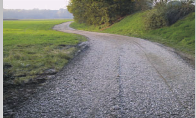
Nachher Mit der Schotter- und Wegefräse HEN-WPF 200 instandgesetzte Flurstraße
