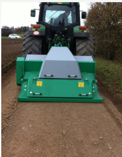
Aufgefräst, pofilert und verdichtet
