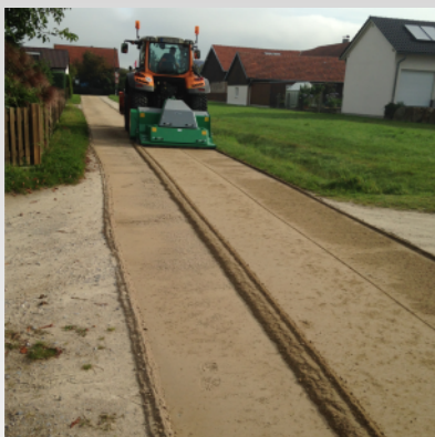
Aufgefräst und profiliert nach einer Überfahrt
